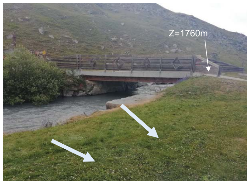
Ouvrage de franchissement du Doron de Belleville aux Bruyères
